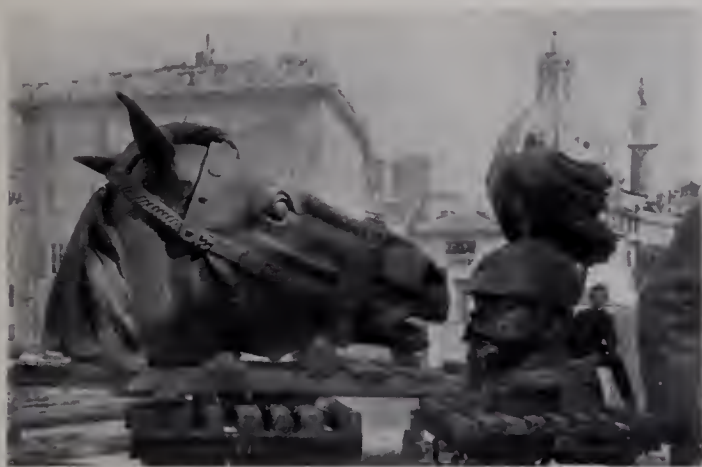
172. — Particolari del gruppo equestre prima della posa in opera
